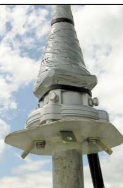
La platine soutenant le roulement. Notez l'étanchéité réalisée sur la partie supérieure du roulement.
