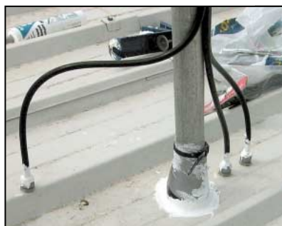
Traversées du mât porteur et des câbles.
